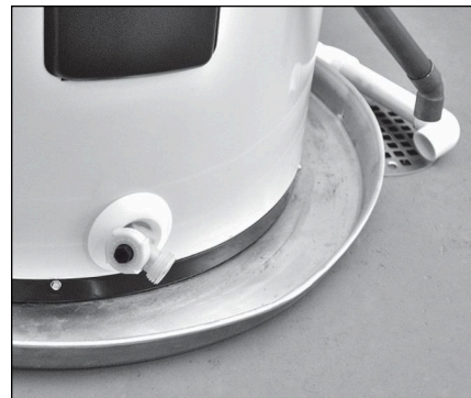
Figure 6 - Un bac de vidange approprié raccordé à une évacuation adéquate peut aider à protéger le revêtement de sol contre les fuites et les gouttes.
