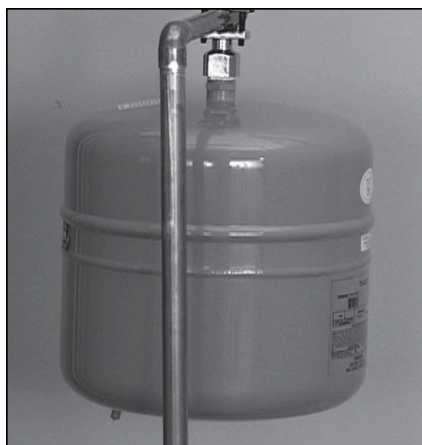
Figure 5 - Un vase d'expansion thermique aide à protéger le système de plomberie de l'habitation contre les pics de pression.
