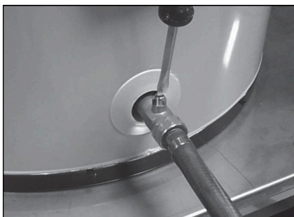
Vidange de l'ancien chauffe-eau.
