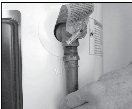
Dépose du tuyau d'évacuation de la soupape de décharge T&P.
